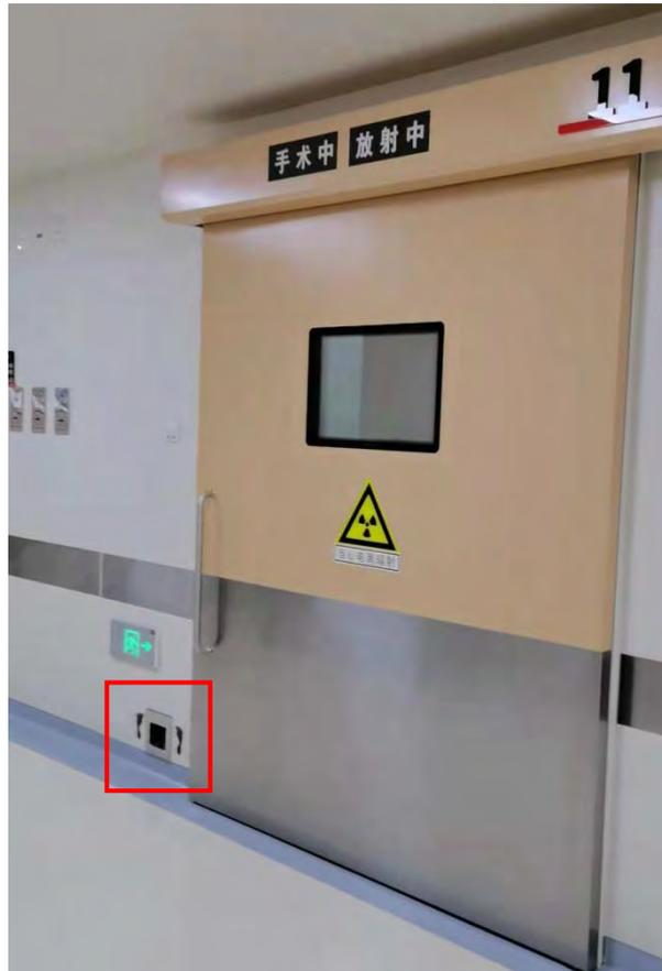
门控制装置(有延迟关闭和防夹功能)
